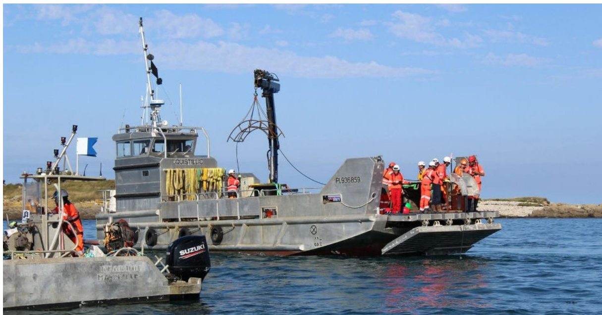
Photo prise lors de l'installation de câble optique sous-marin à Batz
