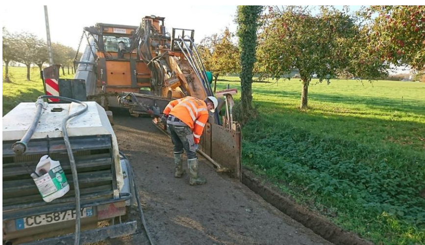
Photo prise lors du déploiement de la fibre à Amanlis (35)
