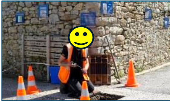
Tirage/raccordement fibre et PTO à la mairie
