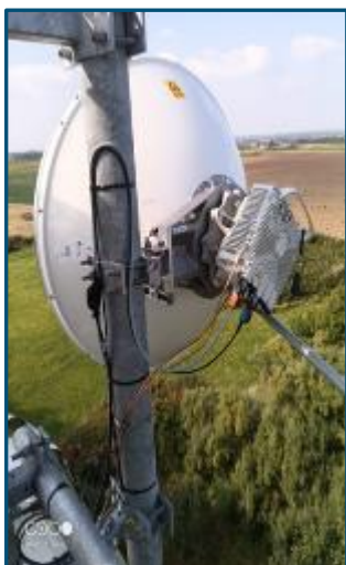
Installation FH et Installation IDU FH sur Plougonvelin
