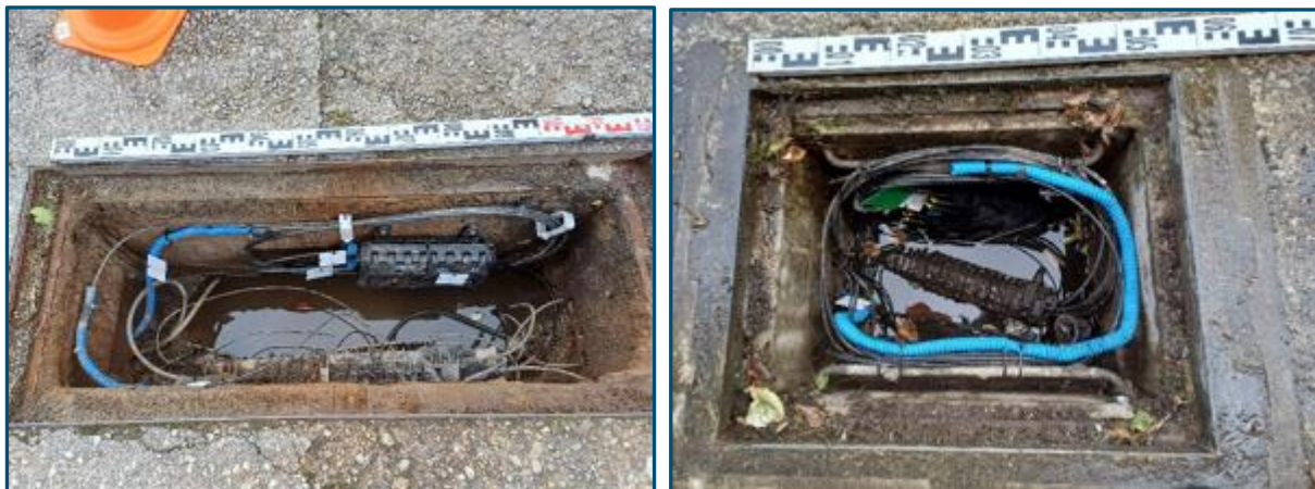
Photos pour clôture du Dossier Fin de Travaux OWF (DFT)
