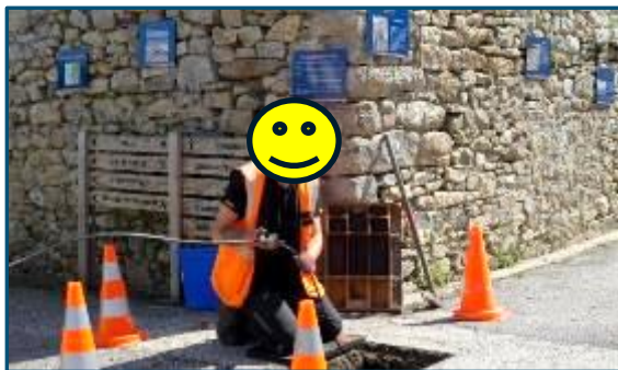
Tirage/raccordement fibre et PTO à la mairie
