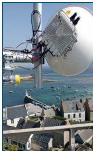
Installation FH et Installation IDU FH sur Molène
